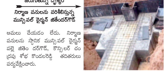
నిర్మాణ పనులను పరిశీలిస్తున్న మున్సిపల్ చైర్మన్ జితేందర్ గౌడ్
